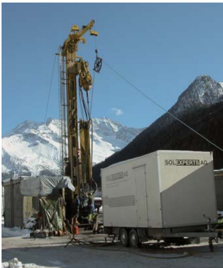
Hydrogeologische Bohrlochversuche mit dem von Solexperts entwickelten Pumpacker-system.
