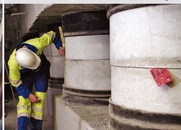
Élément de fondation hiDCon dans le tunnel du Chienberg
