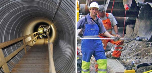
Autoroute A16 Transjurane, construction section Roches-Moutier, Canton de Berne: Mesures Trivec dans une paroi de pieux
