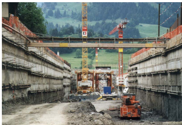
Frutigen: Fouille avec parois ancrées
