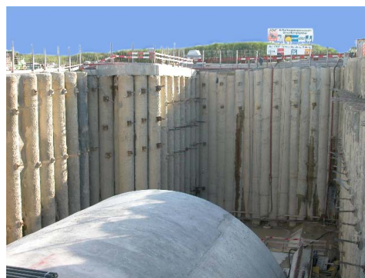
Oenzberg: Tunnel à ciel ouvert
