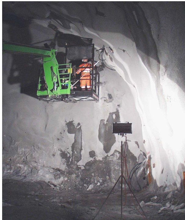
Tunnel de Faido: Ancrage au rocher
