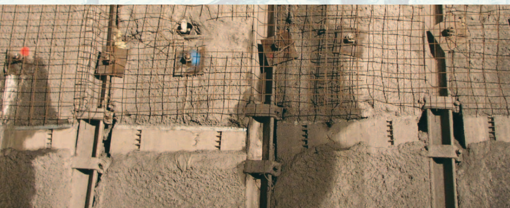
Revêtement en béton projeté compressible avec éléments hiDCon et profils TH
