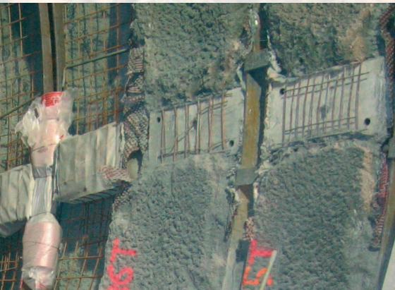
Elément poutre hiDCon pour revêtement de béton projeté
