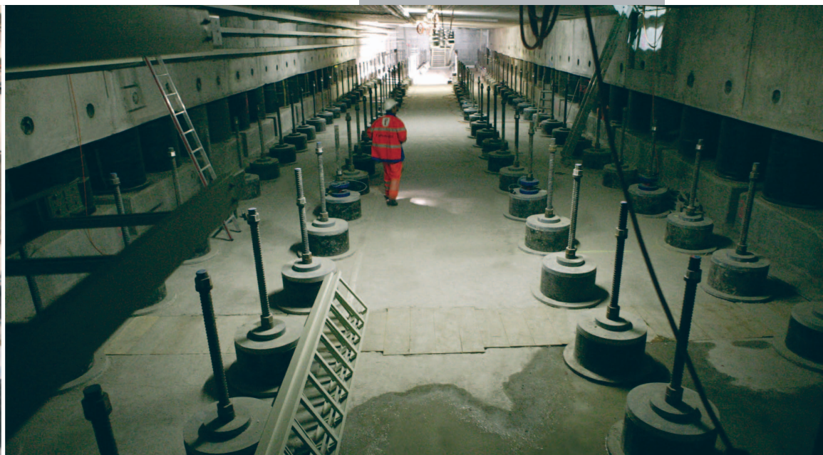
Zone de soulèvement du tunnel routier de Chienberg, Suisse (source: Aegerter & Bosshard AG)
