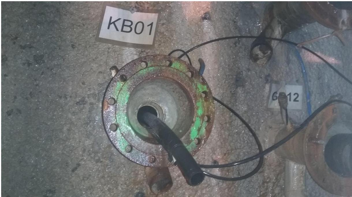
Eine der 15 Temperaturmessbohrungen im Albulatunnel II
