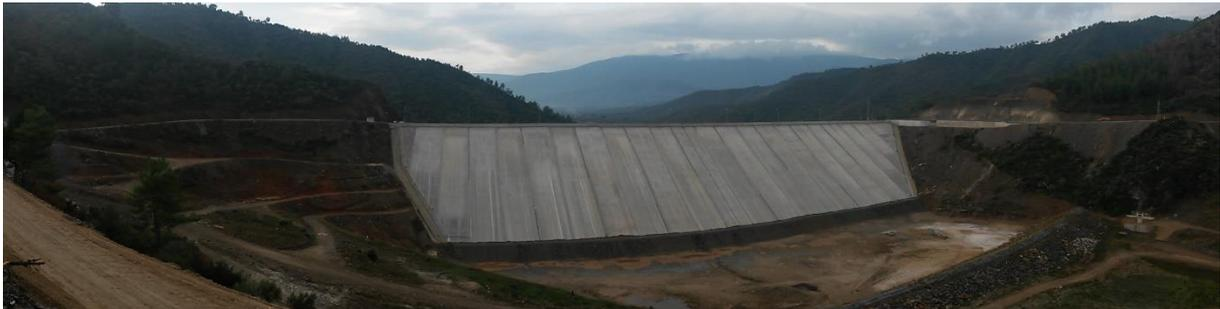
Wasserseitige Betonoberflächendichtung des Derince Dammes
