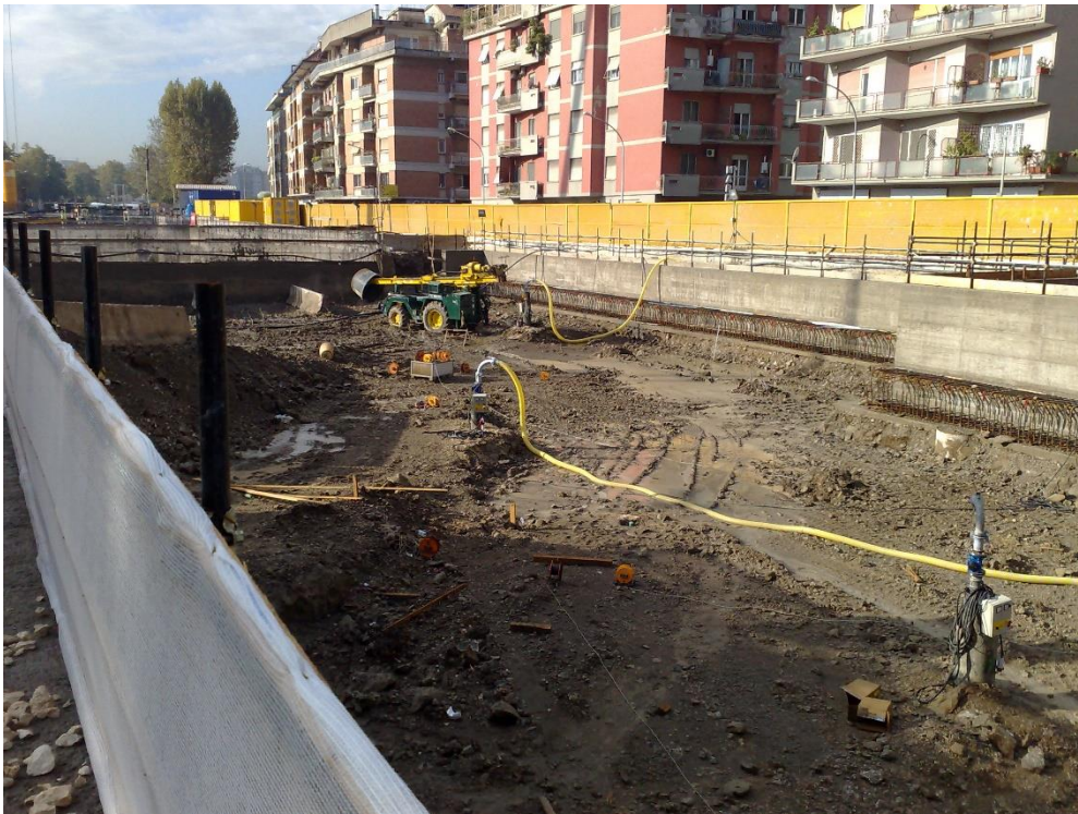
Baustelle Conca d'Oro Metro B1 in Rom, Italien
