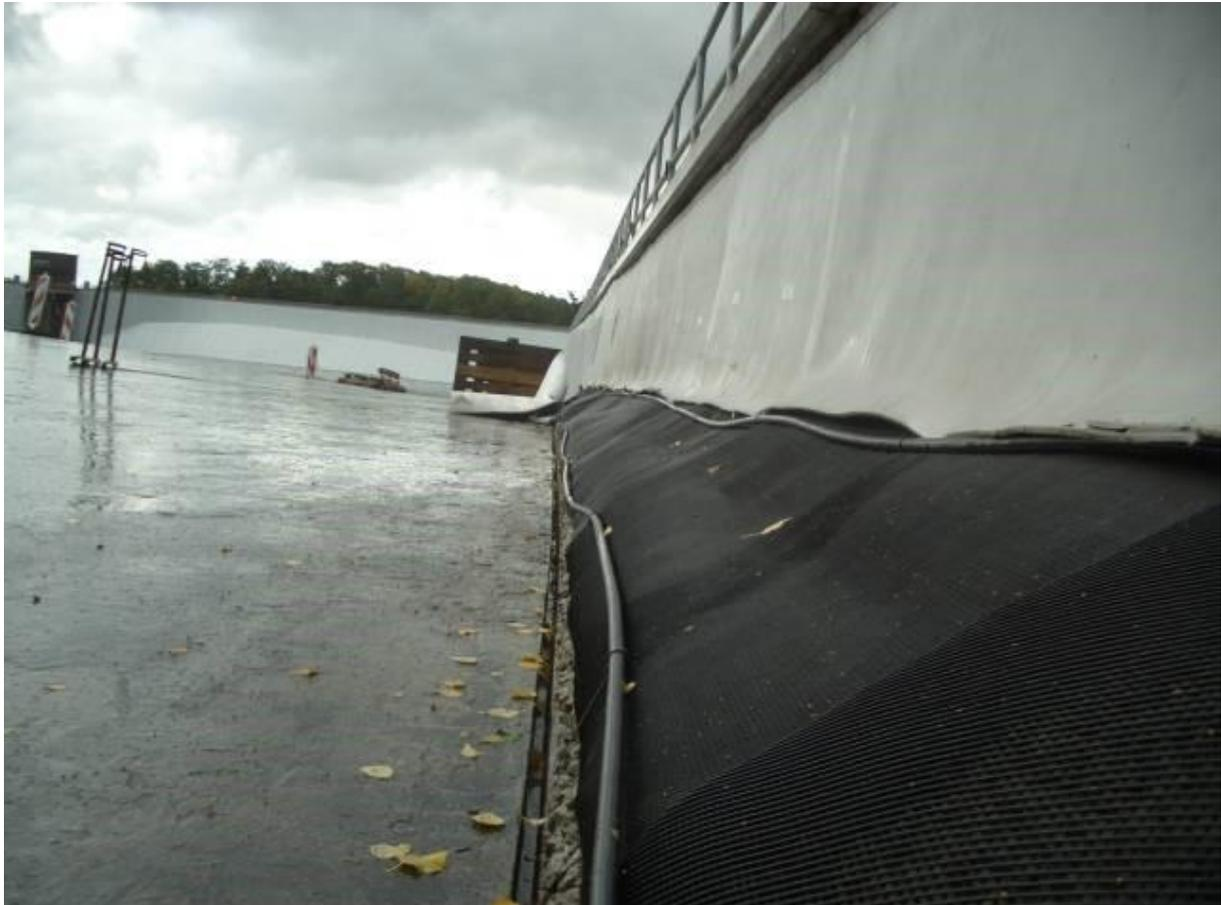
Verlegung der Glasfaserkabel entlang der Kunststoffdichtungsbahn
