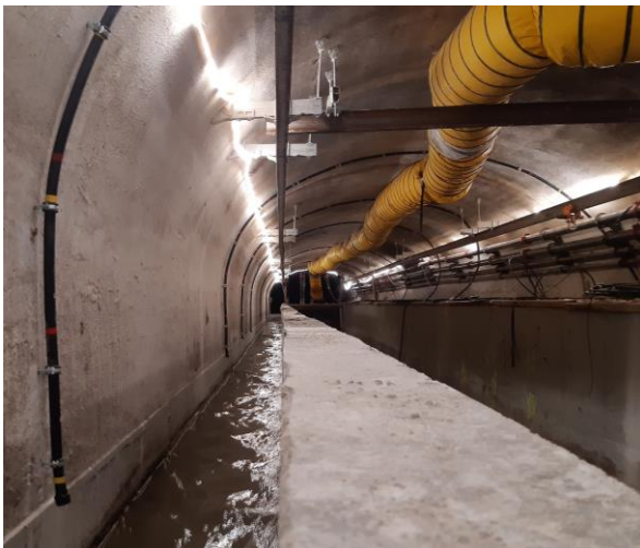
Chantier SBS Lyon Part Dieu – Suivi de la convergence dans un collecteur
