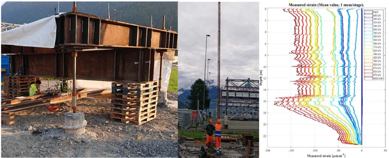
Mesures de déformation réalisées pendant les essais de chargement de trois pieux sur plusieurs profils de fibres optiques installées dans le ferrailage, Bilten (CH)
