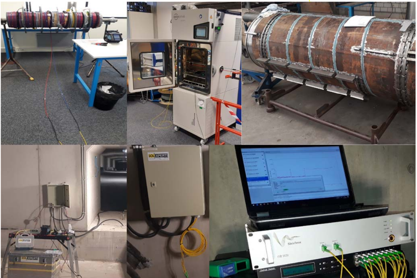
Préparation/connecteurisation/calibration des câbles en atelier, installation sur l'ouvrage, raccordement à l'interrogateur
