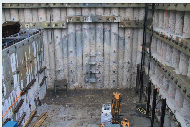
Excavation de la tranchée
