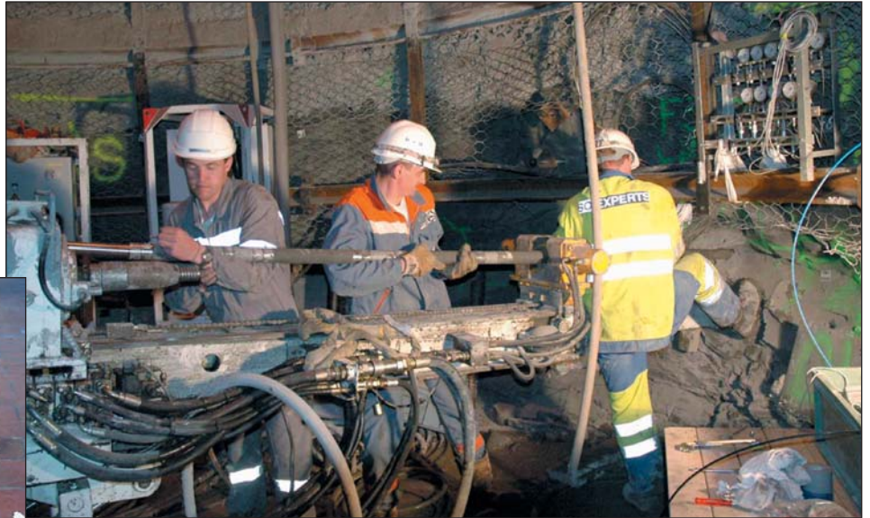
Figure 5 - Retrait du MMPS de test du forage (Photo Antea)
