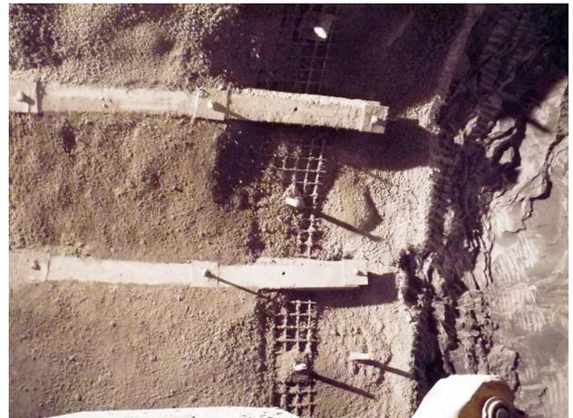
Photo n°3: Caes compressible (hiDCon®) et béton projeté avec treillis
