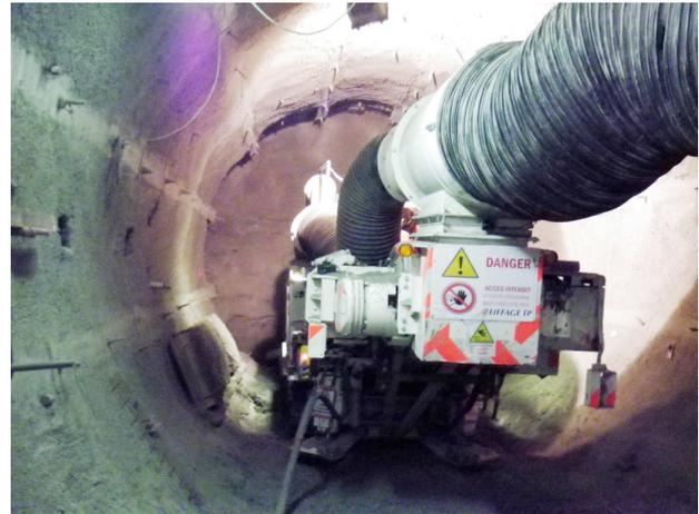
Photo n°1 : Machine à attaque ponctuelle à front
