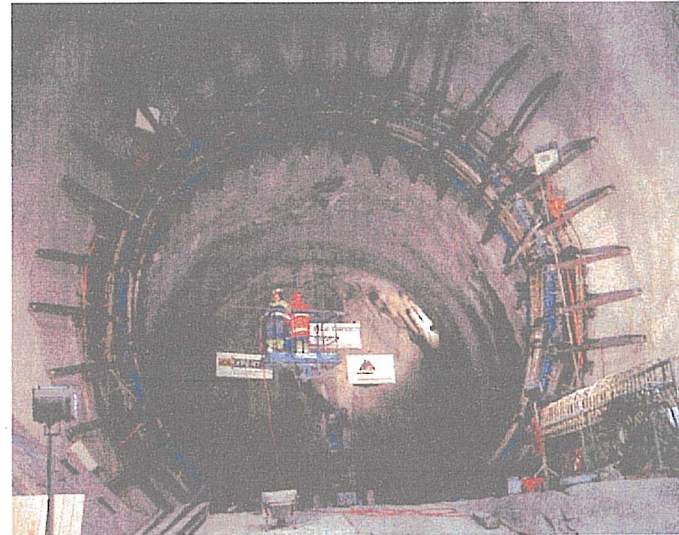
1 Zur Durchörterung von Zonen mit druckhaftem Gebirge kommt im Baulos Sedrun des Gotthard-Basistunnels das Konzept des deformierbaren Stahleinbaus zur Anwendung, das im Großversuch mit 13 m Durchmesser getestet worden ist (Foto:atg)
