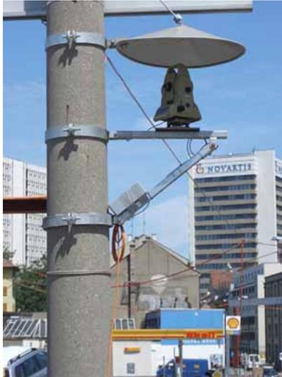
Abb. 3.2.2 Tachymeter zur Überwachung der Häuser Hünigerstrasse,
