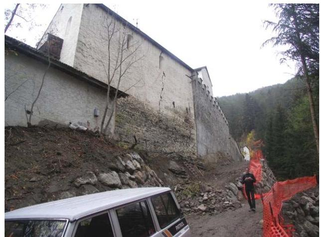
Abb. 7.21: Klostermauer Marienberg (Südtirol) unter der eine verankerte Stützmauer erstellt wurde
