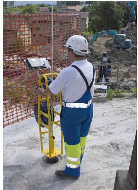
Abb. 7.16: Trivecmessung an verankerter Baugrube
