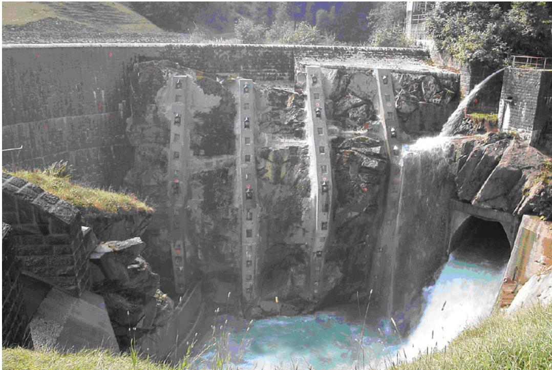
**Abb. 7.1:** Staumauer Pfaffensprung, Sicherung mittels verankerten Betonrippen
