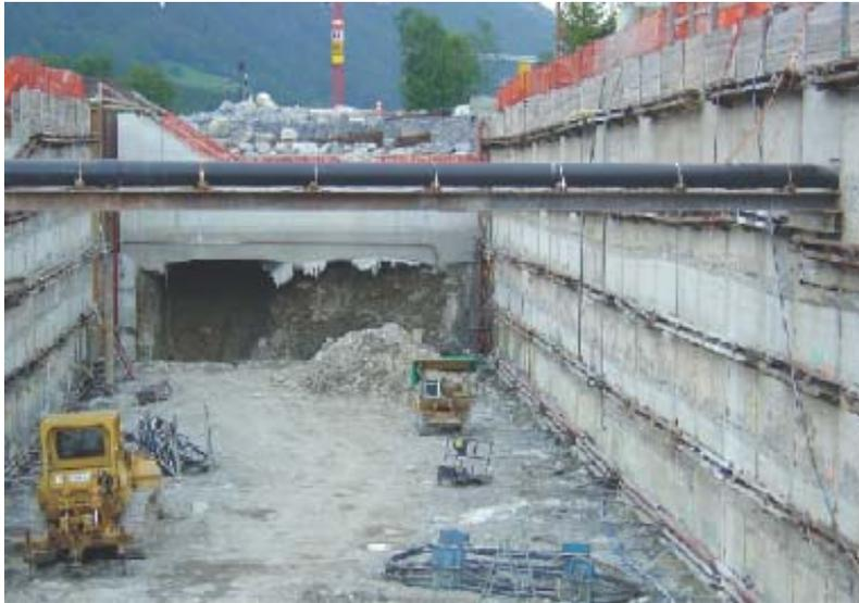
Abb. 7.6: Frutigen Ankerkraftmessung
