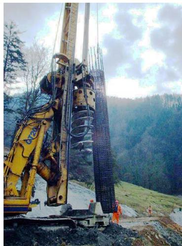
Abb. 5 Versetzen der Pfahlbewehrung
