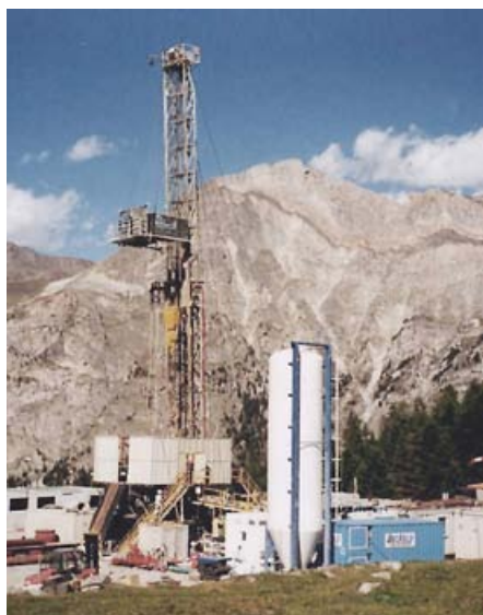
LTF Richtbohrung Etache
