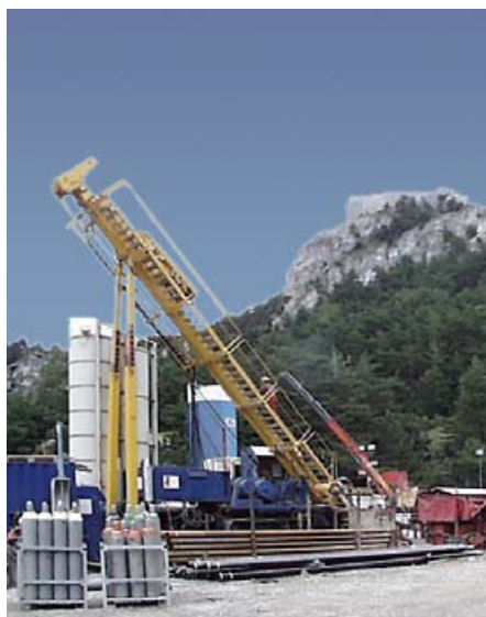
LTF Richtbohrung Avrieux
