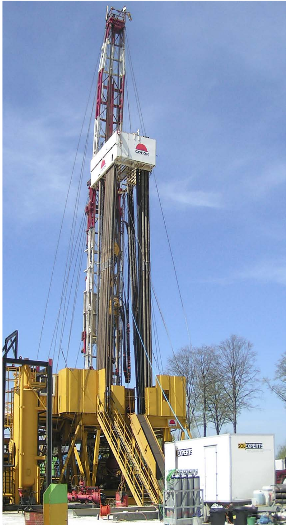
Bure: installation du système à double obturateur «heavy-duty»
