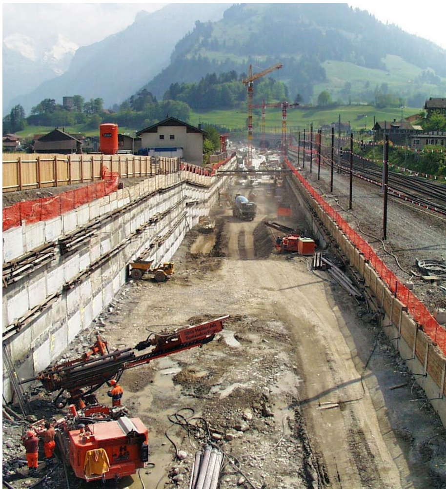
Baugrube südlich der Widibrücke
