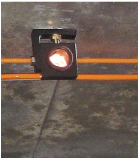
Point de mesure fixé en clé de voûte du tunnel
