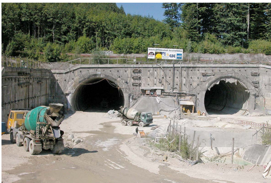
Portails des tunnels, Munimatt
