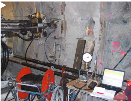
Essai au Dilatomètre
