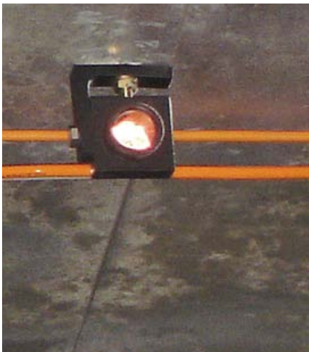
Beobachtungspunkt an der Tunneldecke
