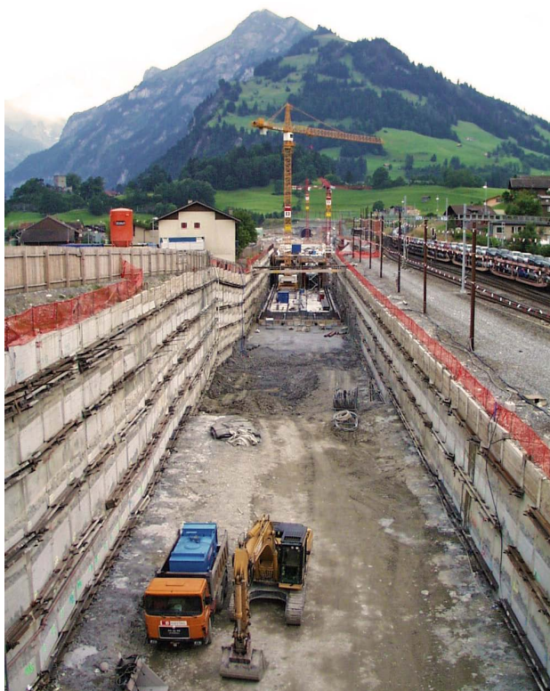
Bild 1: Baugrube südlich der Widibrücke
