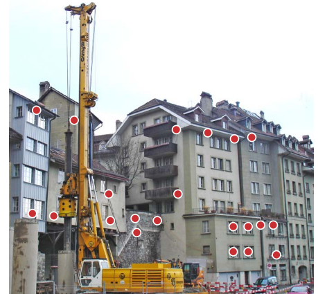
Abbildung 2: Wohngebäude mit Messpunkten (rot)
